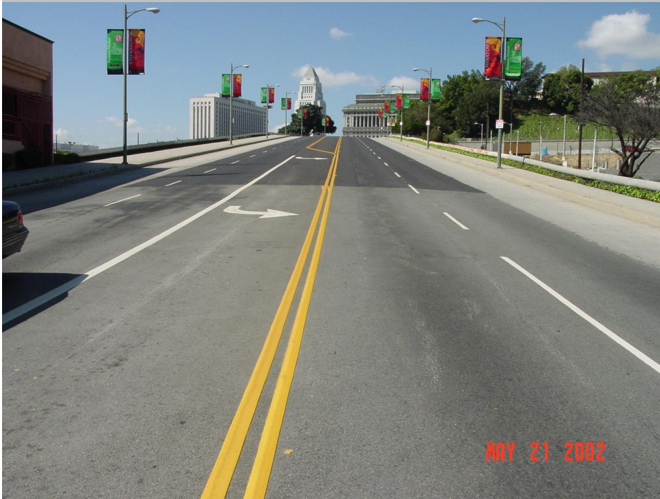
CALLE DE CONCRETO ASFALTICO
